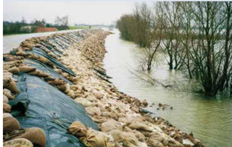
Waal bij Ochten in 1995. De landmacht heeft zandzakken aangebracht uit vrees dat de dijk het zou begeven. >> © Robert 't Hart, Beeldbank Rijkswaterstaat.
