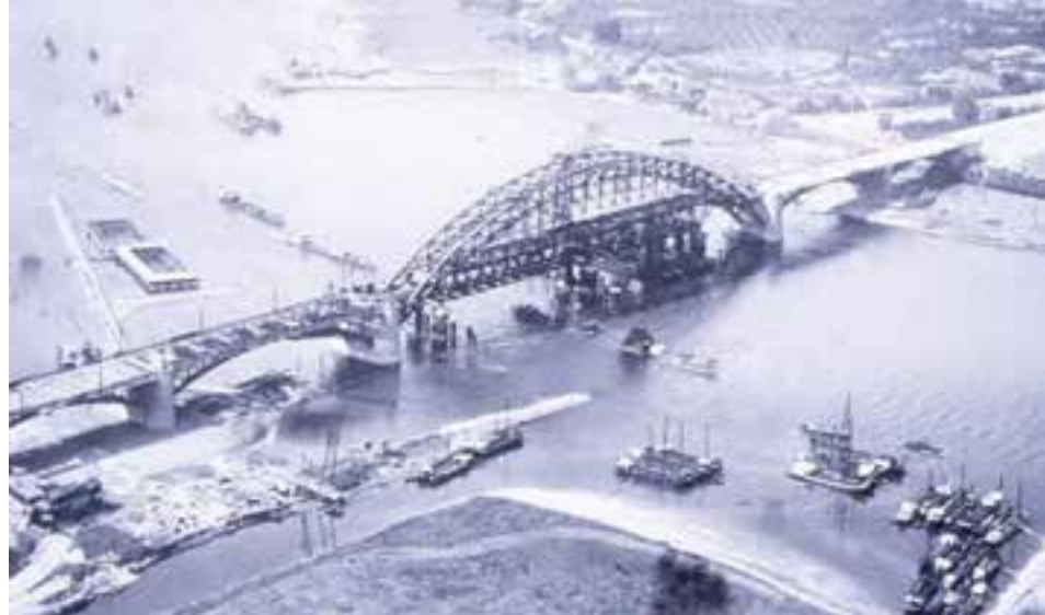
Waalbrug in aanbouw, omstreeks 1935. >> © Noviomagus.nl , maker onbekend.
