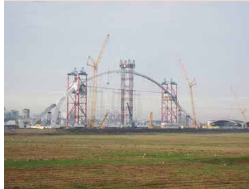
De brug De Oversteek in Nijmegen in aanbouw in 2012. >> © Bj. Schoenmakers, Wikimedia Commons.
